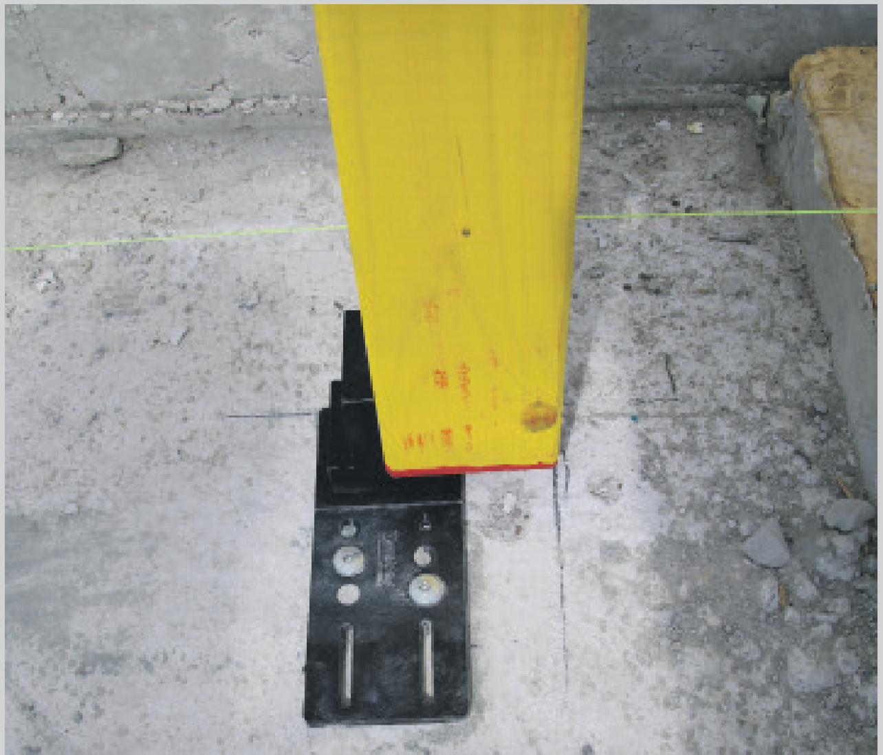
▲ Stap 1. De zwarte funderingsplaat is op de gewenste plaats op fundering bevestigd.
