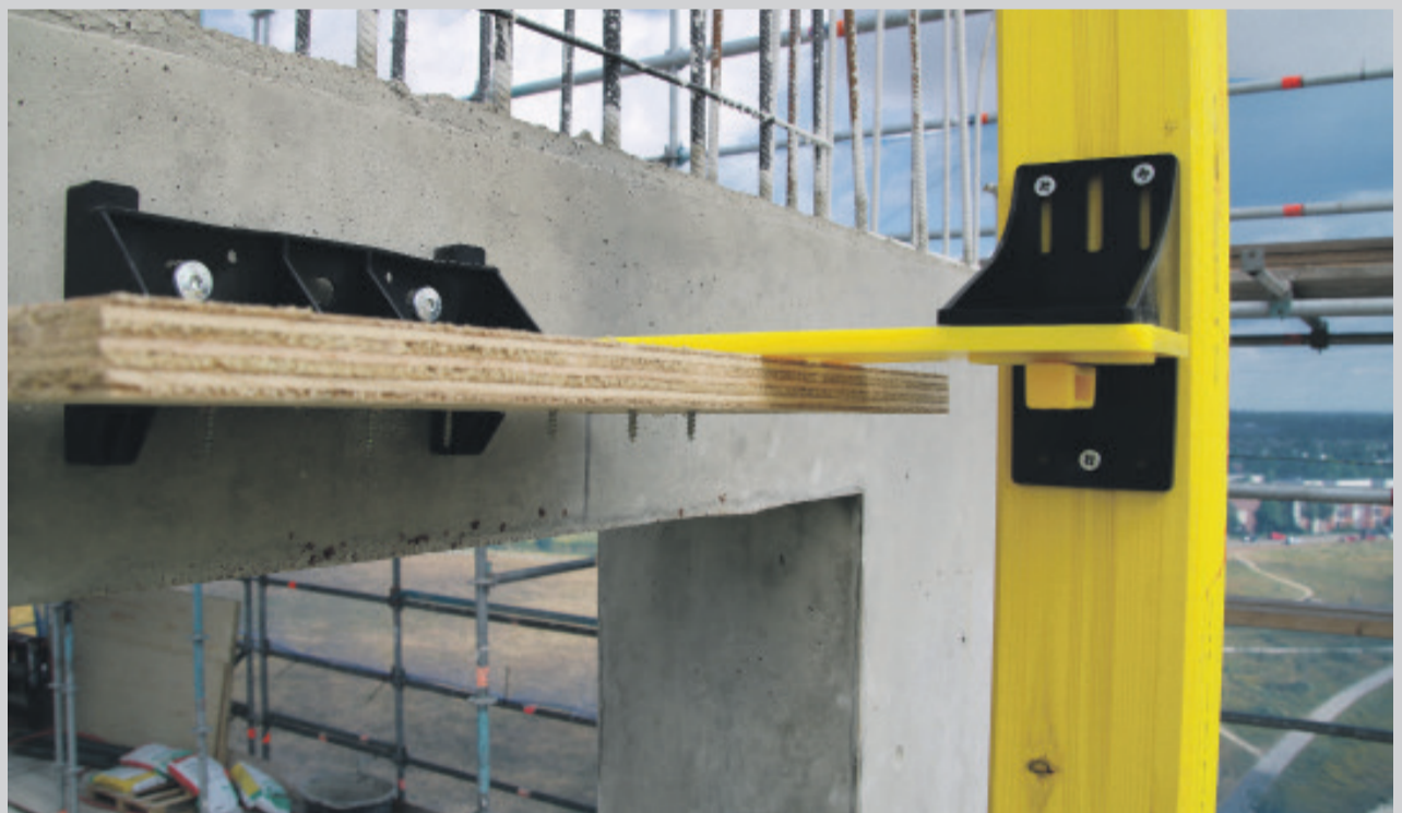
▲ Stap 2. Aan de bovenzijde van het profiel wordt de zwarte profiel hoeksteun geschroefd. Onder de profielsteun wordt een gele stelplaat gefixeerd door de vergrendeling een kwartslag te draaien.
